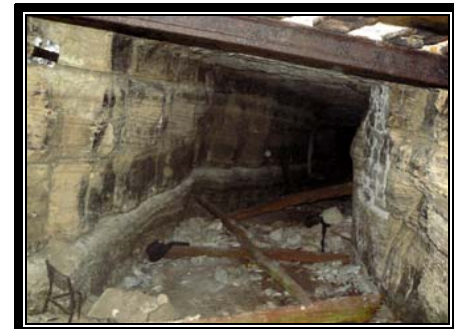
Galleries de seconde masse (Hauteur : ~5 mètres)
