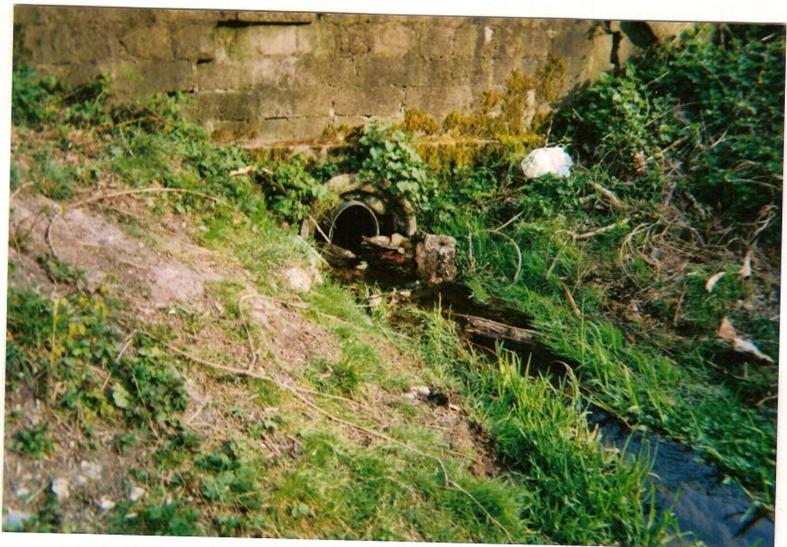
Evacuation de l'eau.
